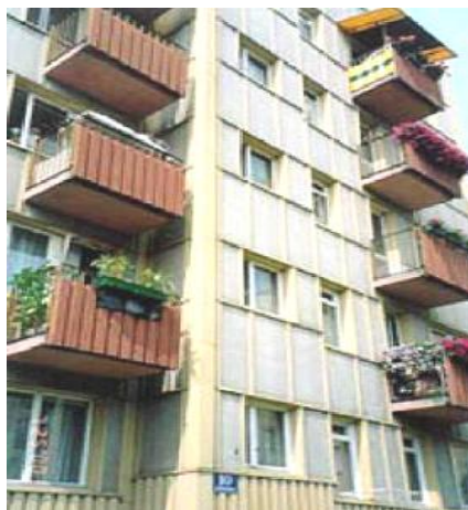
Zdjęcie 10 Elewacja wykonana z płyt azbestowo-cementowych płaskich
