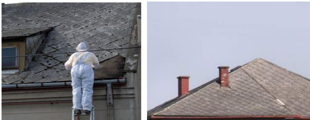
Zdjęcie 8 Płyty płaskie prasowane tzw. szablony lub płyty „karo” (PN-66/B-14040)
