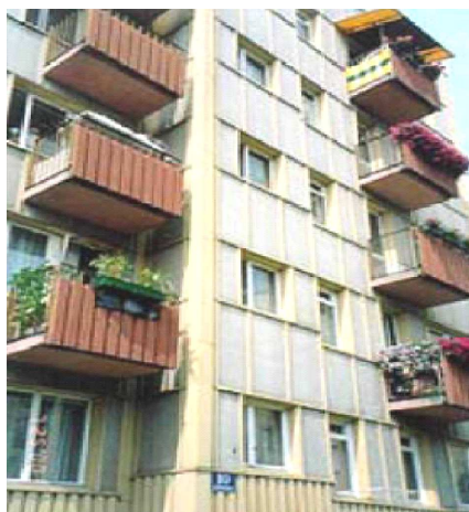
Zdjęcie 10 Elewacja wykonana z płyt azbestowo-cementowych płaskich
