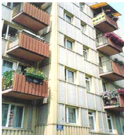
Zdjęcie 10 Elewacja wykonana z płyt azbestowo-cementowych płaskich
