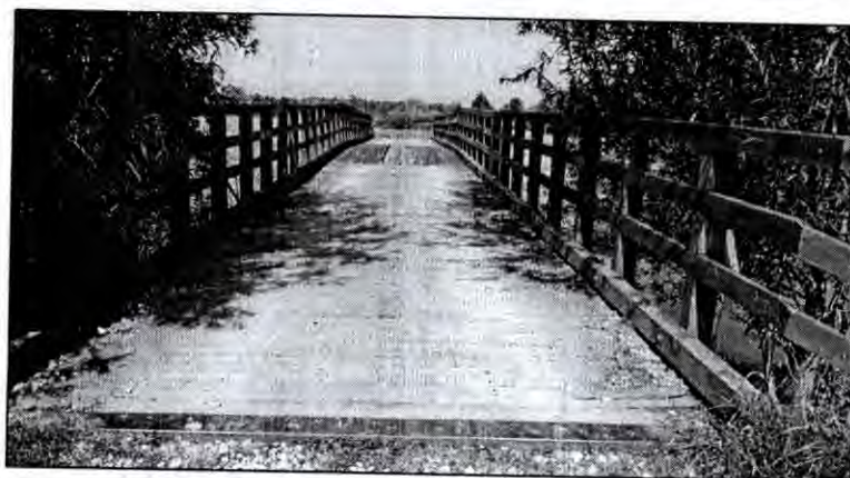
Pokład górny widok ogólny całego mostu
