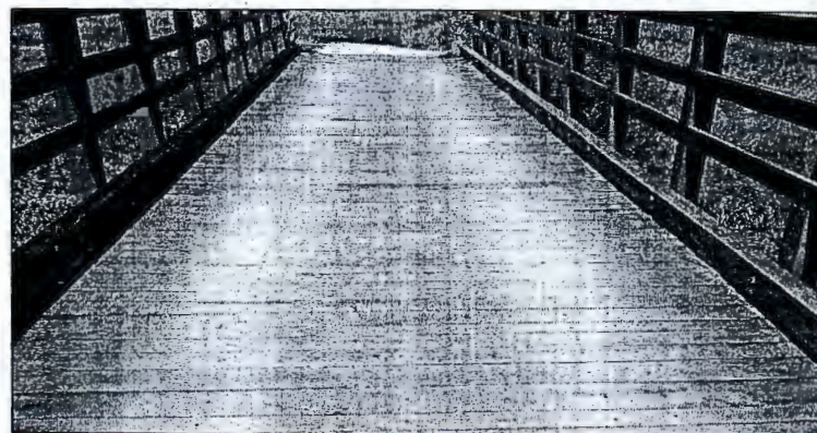
Pokład górny mostu od strony zjazdu na pola
